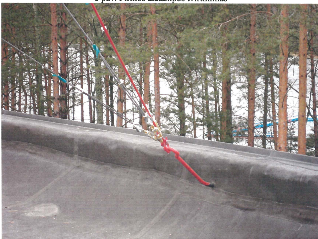
9 pav. Antros atatampos tvirtinimas
