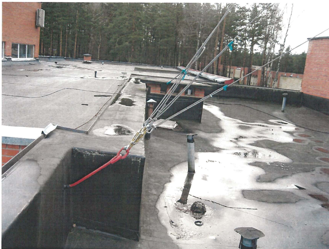
8 pav. Pirmos atatampos tvirtinimas
