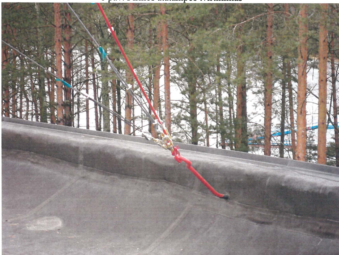
9 pav. Antros atatampos tvirtinimas
