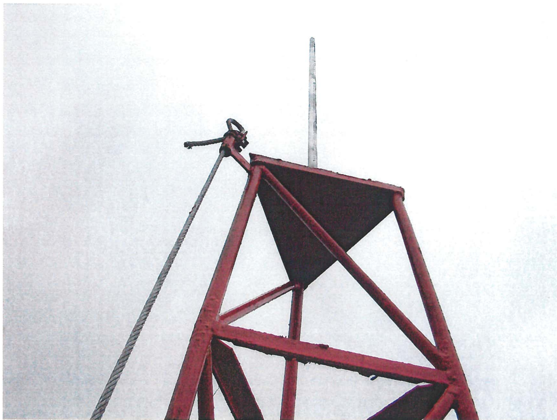
12 pav. Apsauginio lino tvirtinimas bokšto viršuje
