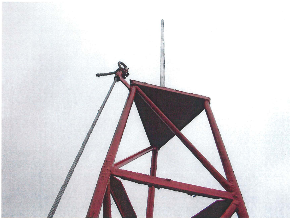
12 pav. Apsauginio lino tvirtinimas bokšto viršuje
