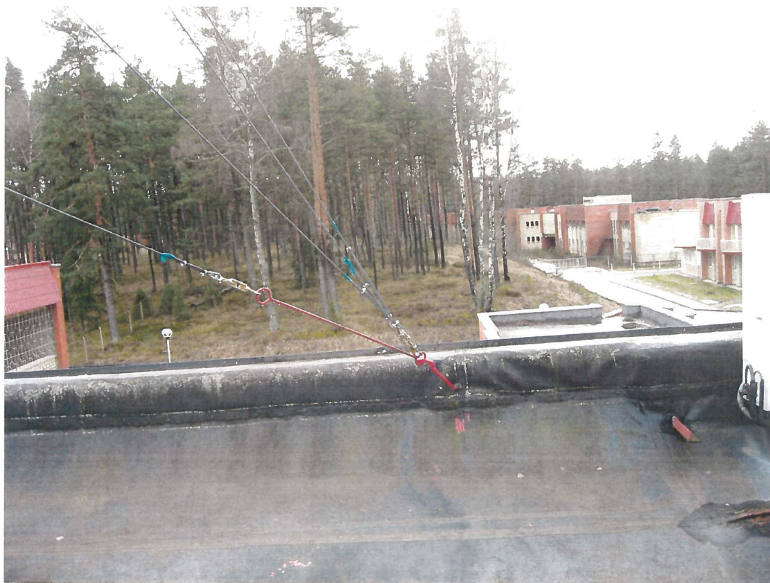
10 pav. Trečios atatampos tvirtinimas
